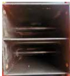
Powierzchnie wymiennika czyścić szczotką lub odkurzaczem.
